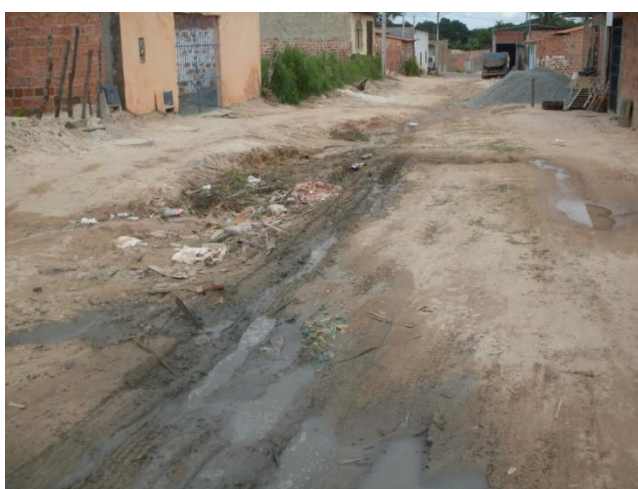
Figura 34 - Bacia 5 - Localidade Novo horizonte – rua com acúmulo de lama devido ao lançamento inadequado de águas servidas - PAC1
