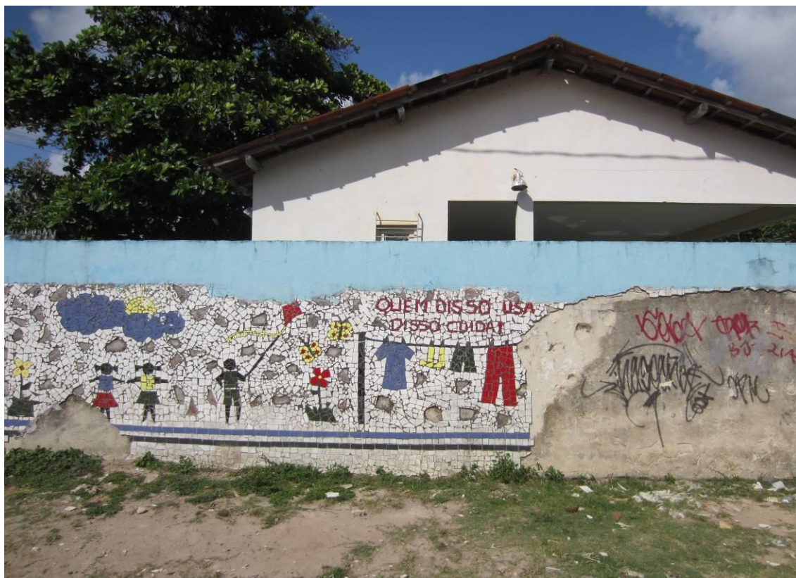
Figura 20 – Posto municipal de saneamento integrado na ZEIS Mangueira
