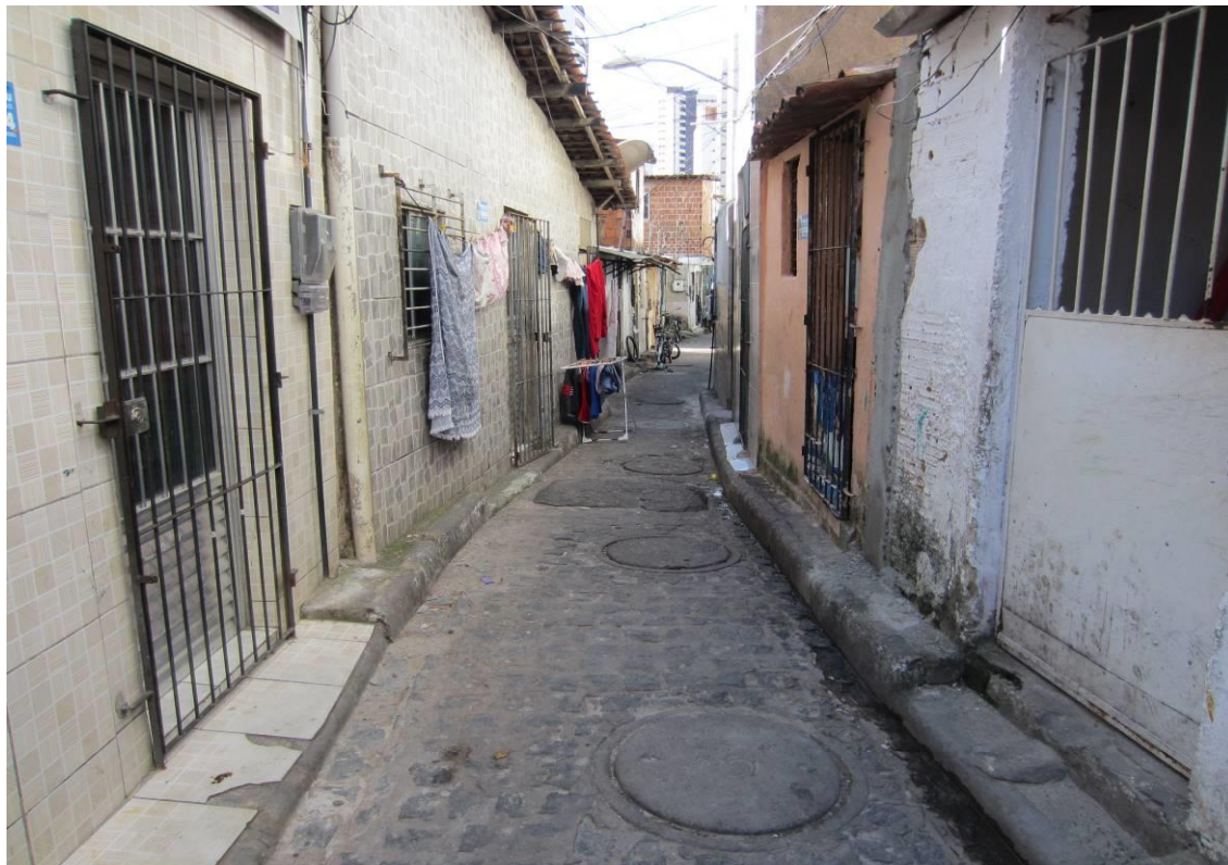
Figura 25 – Rede condominial de coleta de esgoto na ZEIS Mangueira da Torre
