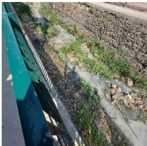
Figura 50. Córrego Sapé à montante – água turva, com presença de esgoto, forte mau odor
