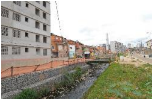
Figura 9. Canalização em gabião (obras do Sapé)
