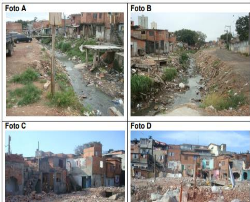
Figura 27. Ocupação anterior a intervenção no canal do Córrego Sapé no Trecho 2
