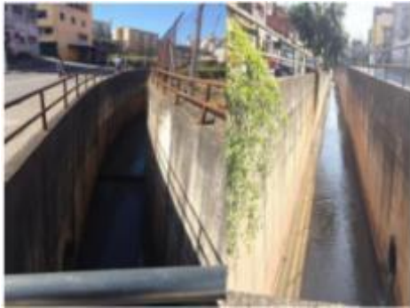
Figura 8. Canalização em concreto (Conjunto 3 Marias, São Bernardo do Campo)
