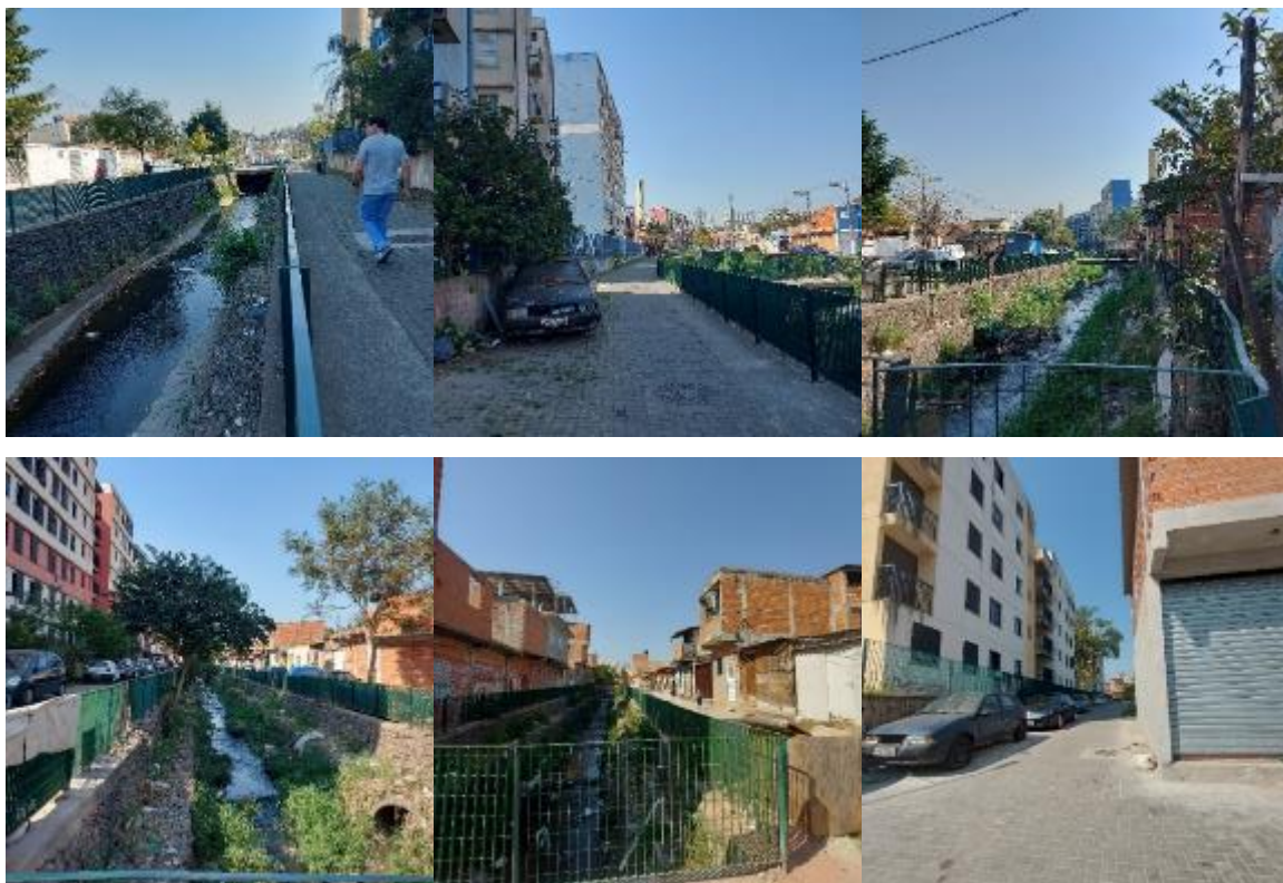
Figura 29. Trecho 2 no pós-intervenção Fonte: foto de autoria própria, 2023.
