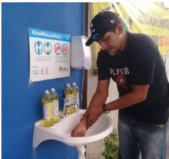
Figura 2 - Hidroponto instalado na sede da associação. Foto: Habitat Brasil
