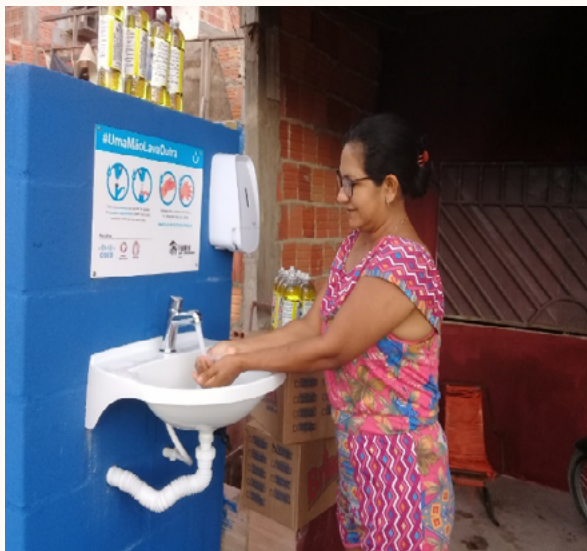
Figura 1 - Hidroponto instalado na entrada da comunidade Rei Davi. Foto: Habitat Brasil
