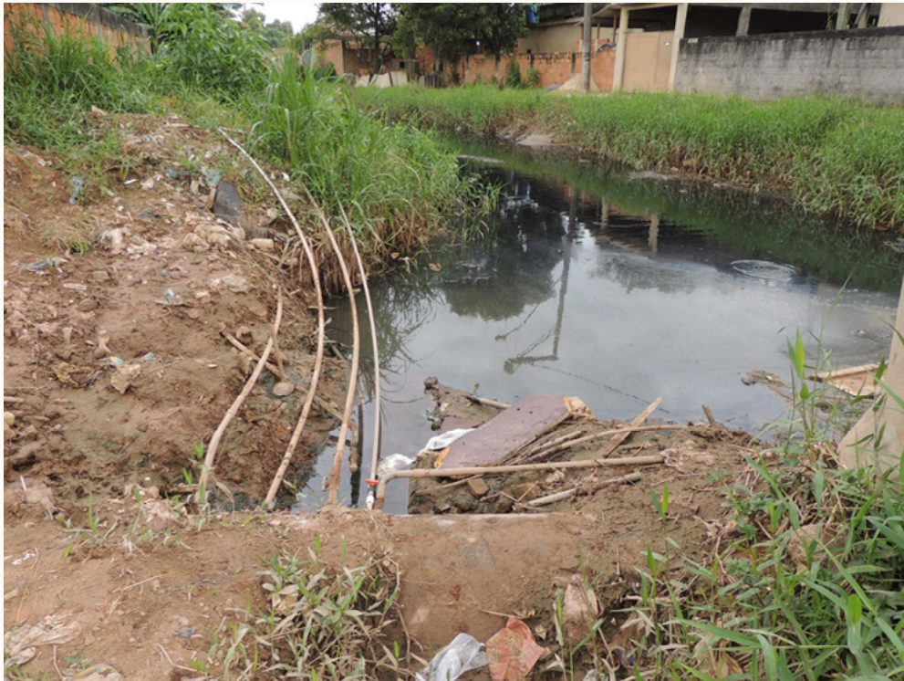
Figura 1 - Ligações irregulares na adutora da Petrobras. Foto: Suyá Quintslr
