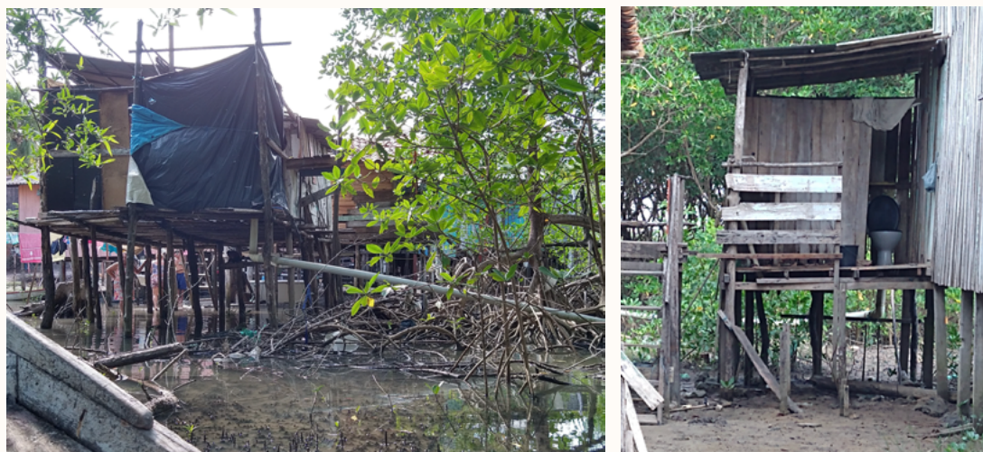
Figura 2 – Situação de moradias e respectivas instalações sanitárias em área de mangue. Foto: Vania Neu
