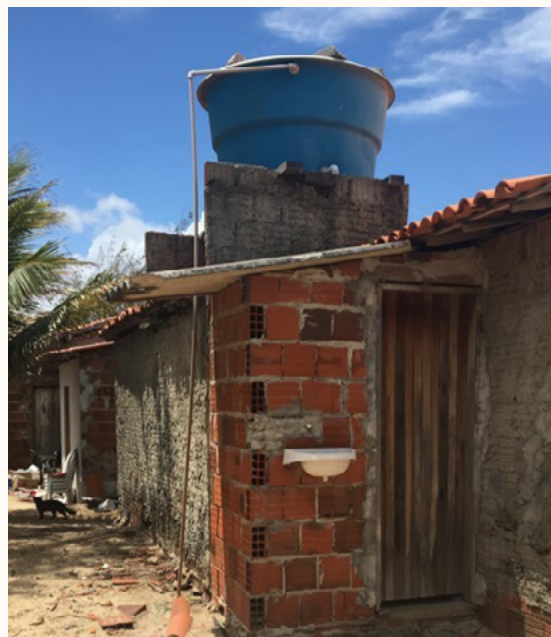
Aspecto geral da comunidade: padrão de construção e forma de abastecimento/armazenamento de água. Foto: Paula Tomaz, 2018
