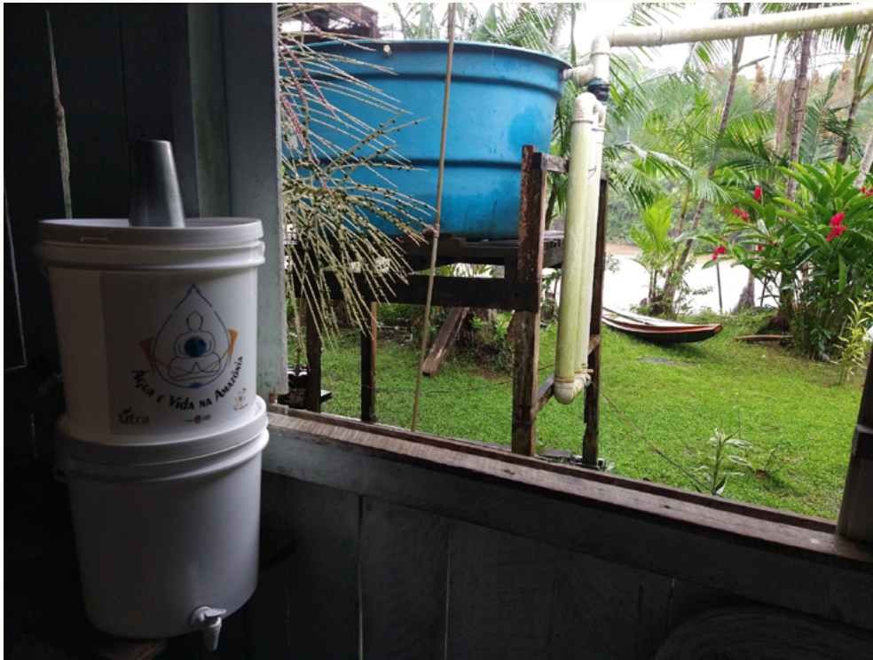
Figura 1 – Sistema de captação de água de chuva. Foto: Vania Neu
