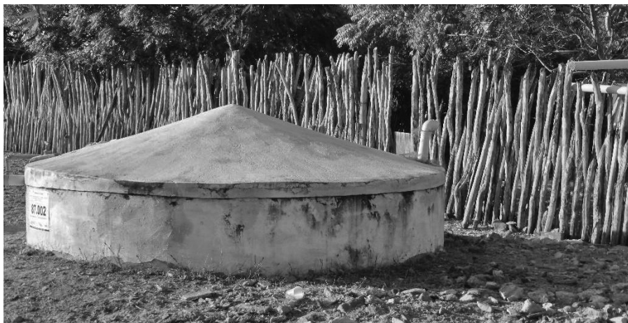
Figura 3: Cisterna de abastecimento rural no município de Forquilha
